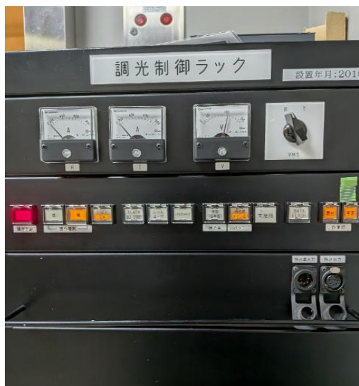
持込み照明卓接続コンセント
